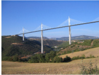
Fig.H.7: Das Millau-Viadukt in Frankreich, die höchste Brücke der Welt. Stahl und Beton, 2,5 km lang und 353 m hoch.
