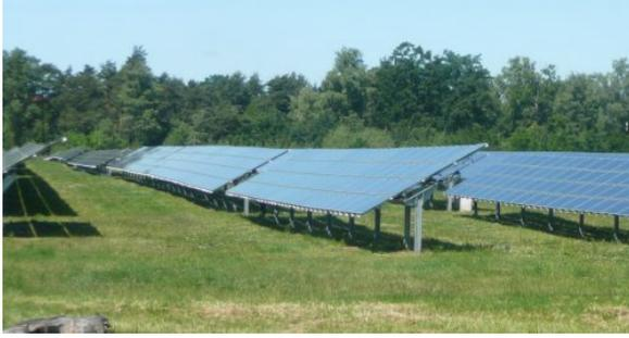
Fig. D.1b: Anordnung der Module einer Solarfarm, hier der Solarpark Königsbrück bei Dresden (Foto: Wikimedia Commons). Der Abstand der Modulreihen zueinander ist etwa das drei- bis vierfache der Modulflächen-Höhe, gemessen vom oberen zum unteren Rand.
