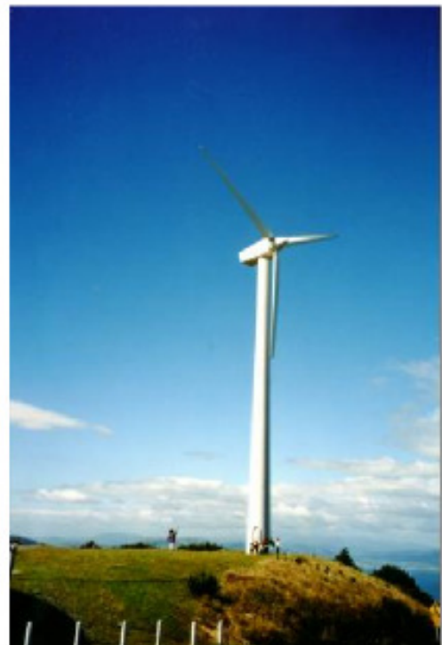
Fig.B.3: Die Brooklyn Windmühle bei Wellington, Neuseeland, mit Leuten zum Maßstabsvergleich. An einem windigen Tag erzeugte diese Windmühle 60 \text{ kW} ( 1400 \text{ kWh/d} ). Foto von Philip Banks
