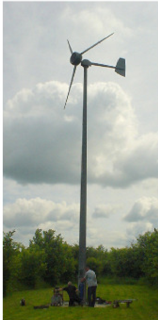
Fig.B.10: Eine Iskra 5 kW Turbine mit 5,5 m Durchmesser [www.iskrawind.com] bei der jährlichen Wartung. Diese Turbine steht in Hertfordshire (nicht einer der windigsten Orte in England) in 12 m Höhe und hat einen mittleren Leistungs-Output von 11 kWh pro Tag. Eine Windfarm mit Maschinen dieser Performance, je eine auf 30 m x 30 m, hätte eine Energiedichte pro Flächeneinheit von 0,5 W/m 2 .
