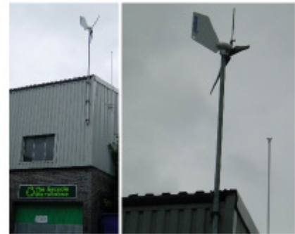
Fig.B.9: Eine Ampair „600W“ Mikroturbine. Die mittlere Leistung, die von dieser Mikroturbine in Lemington Spa erzeugt wird, ist 0,037 kWh pro Tag (1,5 W).
