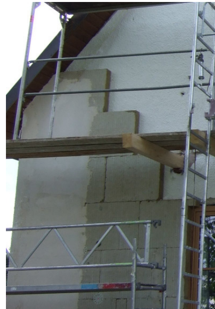
Fig. 29.6: Außenwanddämmung an einem Altbau. Foto mit freundlicher Genehmigung von Pia Huber.
