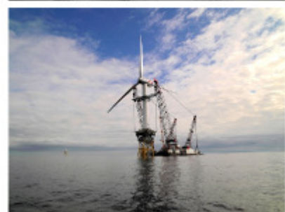
Fig.10.8: Errichtung der Beatrice Demonstrations-Offshore-Windfarm in tiefem Wasser. Foto mit freundlicher Unterstützung von Talisman Energy (UK) Limited.
