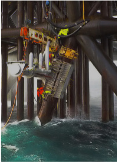
Fig.10.4: Die Magnus-Plattform im nördlichen englischen Sektor der Nordsee enthält 71.000 Tonnen Stahl. Im Jahr 2000 lieferte diese Plattform 3,8 Millionen Tonnen Öl und Gas – eine Leistung von 5 GW. Kosten der Plattform: 1,1 Milliarden €. Foto von Terry Cavner.
