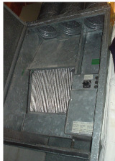
Fig.E.11: Der Wärmetauscher im „Heatkeeper“
