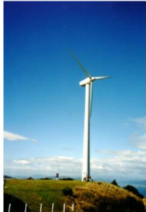
Fig.B.3: Die Brooklyn Windmühle bei Wellington, Neuseeland, mit Leuten zum Maßstabsvergleich. An einem windigen Tag erzeugte diese Windmühle  $60 \text{ kW}$  ( $1400 \text{ kWh/d}$ ). Foto von Philip Banks
