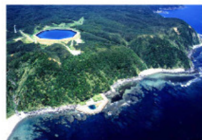
Fig.26.11: (unten) Okinawa Pumpspeicherkraftwerk, dessen Unterwasser der Ozean ist. Gespeicherte Energie: 0,2 GWh. Foto mit freundlicher Genehmigung von J-Power www.ieahydro.org
