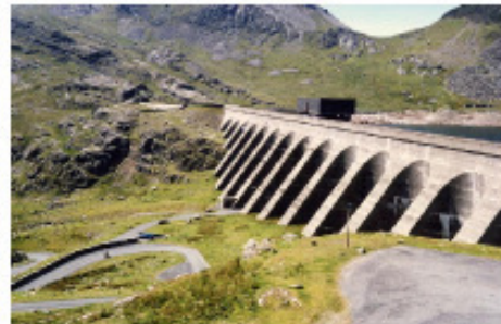
Fig.26.6: Llyn Stwlan, der obere Speichersee des Ffestiniog Pumpspeicherwerks in Nord-Wales. Gespeicherte Energie: 1,3 GWh. Foto von Adrian Pingstone
