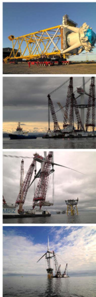
Fig.10.8: Errichtung der Beatrice Demonstrations-off-shore-Windfarm in tiefem Wasser. Foto mit freundlicher Unterstützung von Talisman Energy (UK) Limited.
