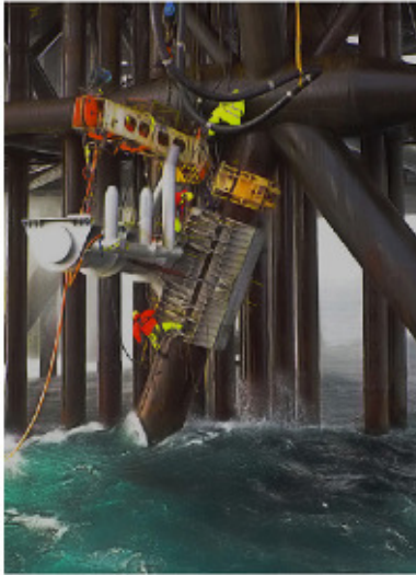
Fig.10.4: Die Magnus-Plattform im nördlichen englischen Sektor der Nordsee enthält 71.000 Tonnen Stahl. Im Jahr 2000 lieferte diese Plattform 3,8 Millionen Tonnen Öl und Gas – eine Leistung von 5 GW. Kosten der Plattform: 1,1 Milliarden €. Foto von Terry Cavner.
