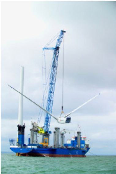
Fig.10.1: (links) Kentish Flats – eine off-shore Windfarm in seichtem Wasser. Jeder Rotor hat einen Durchmesser von 90 m, Achshöhe 70 m. Jede „3 MW“-Turbine wiegt 500 Tonnen, die Hälfte davon das Fundament. Foto mit freundlicher Genehmigung © Elsam (elsam.com)
